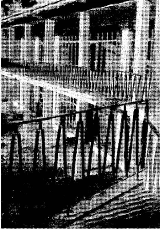
Deutsche Schule Addis Abeba, Schulneubau 1957
