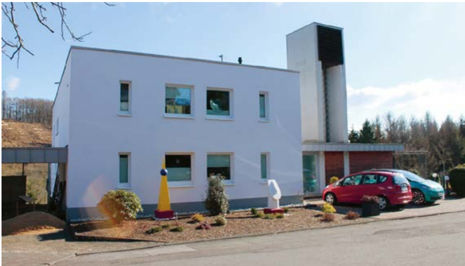
Abb. 103: Die zum Privatwohnhaus umgebaute Rogate-Kirche in Lindlar
