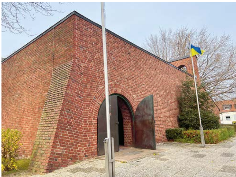
Abb. 8: Herzogenrath-Merkstein, St. Johann Baptist
