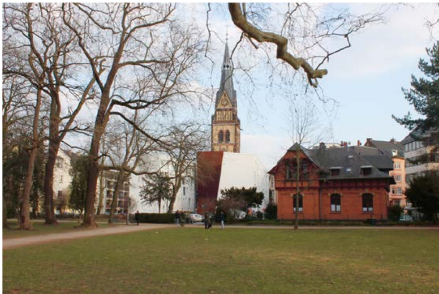
Abb. 105: Ansicht der umgebauten Christuskirche mit ihren beiden skulpturalen Wohn- und Gesch.ftsfügel und dem mittig dazwischenliegendem Kirchenraum mit dem erhaltenen neugotischen Kirchturm
