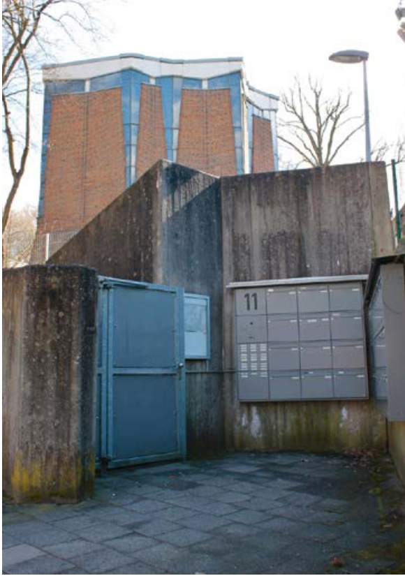
Abb. 102: Die Klosterkirche des ehemaligen Servitinnenklosters und der angeschlossenen Jugendbildungsstätte St. Swibert in Düsseldorf wurde zwischen 2007 und 2012 in zwei Maisonette-Wohnungen mit Dachterrassen umgewandelt. Der Umbau der 1968 von Hans Hass (1931–1989) fertiggestellten Anlage wurde denkmalpflegerisch begleitet.
