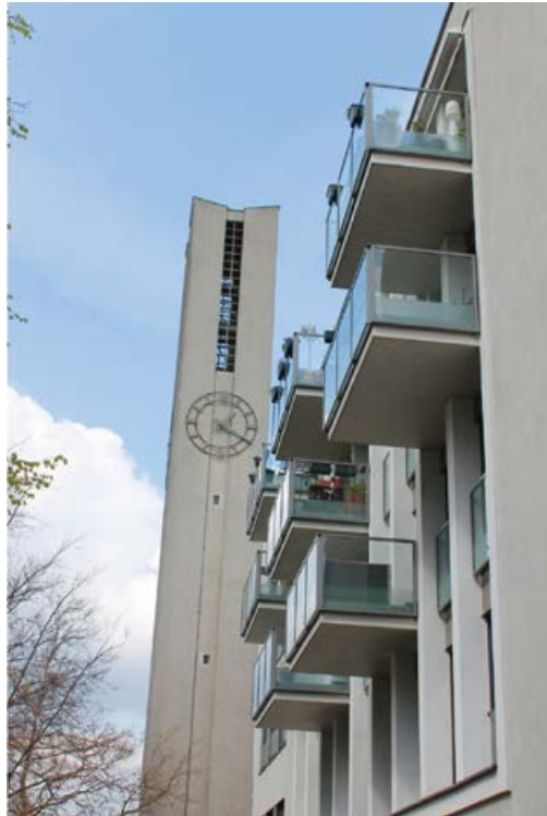
Abb. 104: Der erhaltene Campanile neben dem ausgebauten Kirchenschiff des Lukas-K-Hauses in Essen
