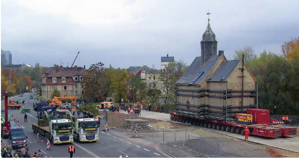
Abb. 1: Translozierung der Emmauskirche von Heuersdorf nach Borna, Sachsen im Oktober 2007
