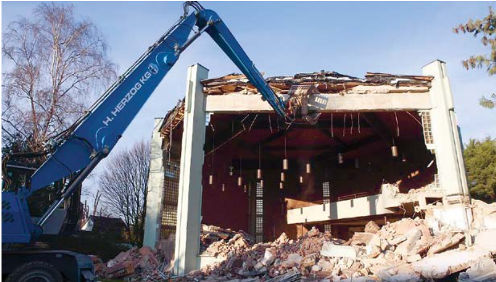
Abb. 23: Abriss des Gemeindezentrums Mülfort in Mönchengladbach
