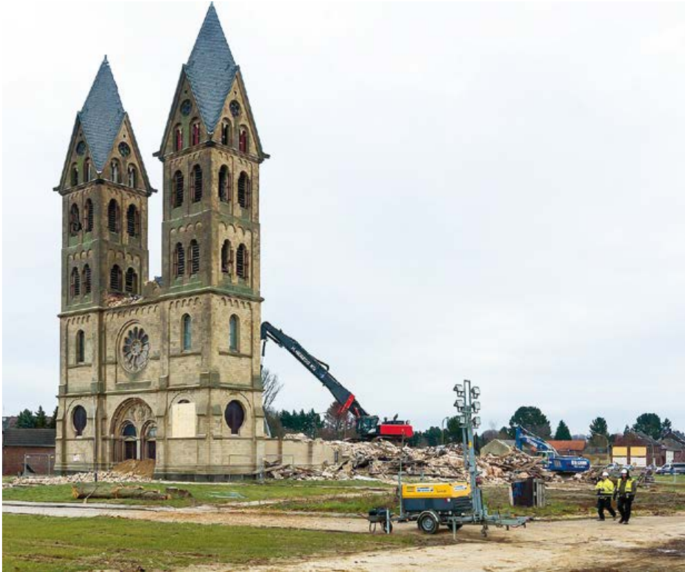
Abb. 2: Abriss des „Immerrather Domes“ (St. Lambertus) im Braunkohlerevier Garzweiler, Januar 2018
