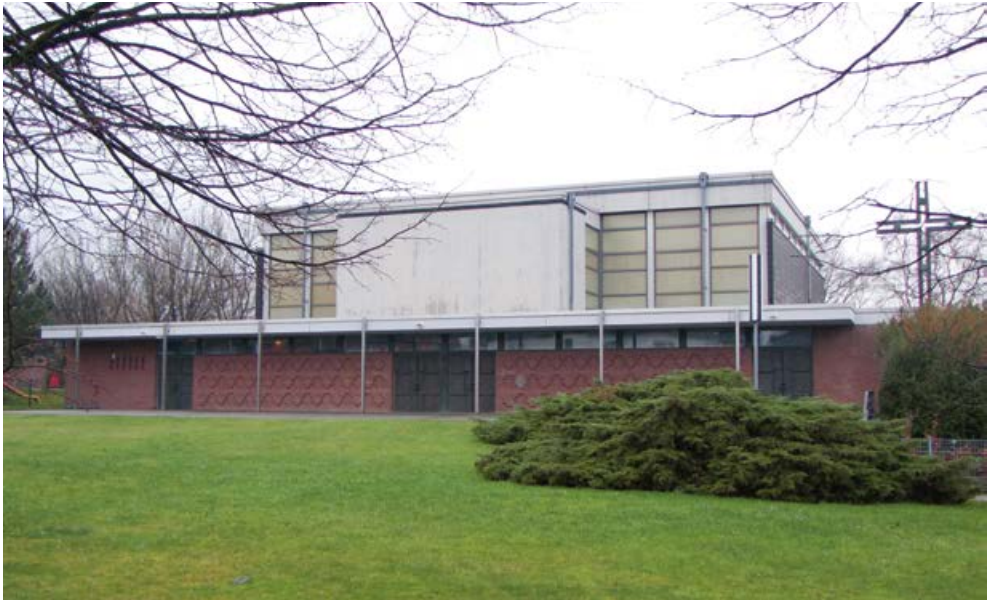
Abb. 25: Aachen-Brand, Erlöserkirche, erfasst im Rahmen des Inventarisationsprojekt vom LVR-Amt für Denkmalpflege im Rheinland.
