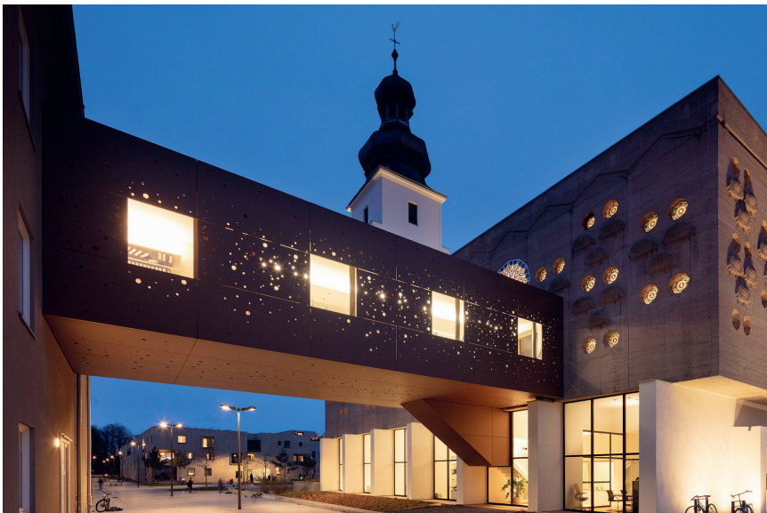
Abbildung 2: Köln-Sülz, ehem. kath. Waisenhauskirche Heilige Familie von Gottfried Böhm, 1955, 2014–2020 Umnutzung und Umbau zu Büro- und Veranstaltungsgebäude durch nebel pössl architekten (Quelle: HG Esch)
