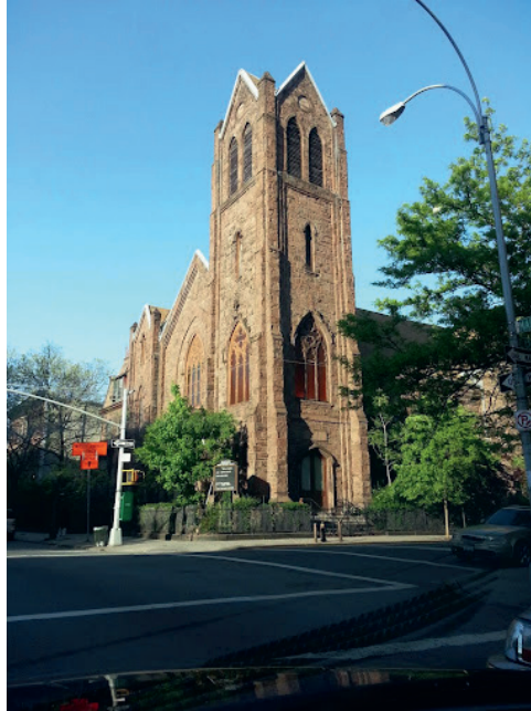
Abbildung 12: Außenansicht Metropolitan Community United Methodist Church (Quelle: Denham Wolf)
