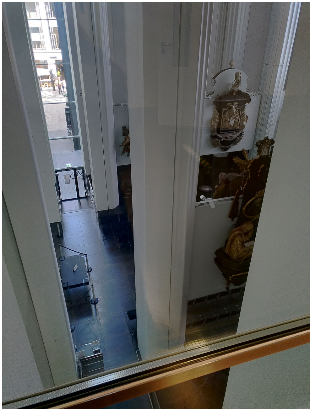
Abb. 47: Paulinum: Glasfugen, Blick vom Rechenzentrum durch das Paulinum Richtung Grimmaische Straße, Foto: Kerstin Menzel
