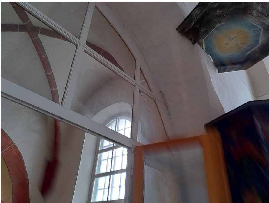
Abb. 35: Kirche Deuben, Detail Trennwand, Foto: Kerstin Menzel
