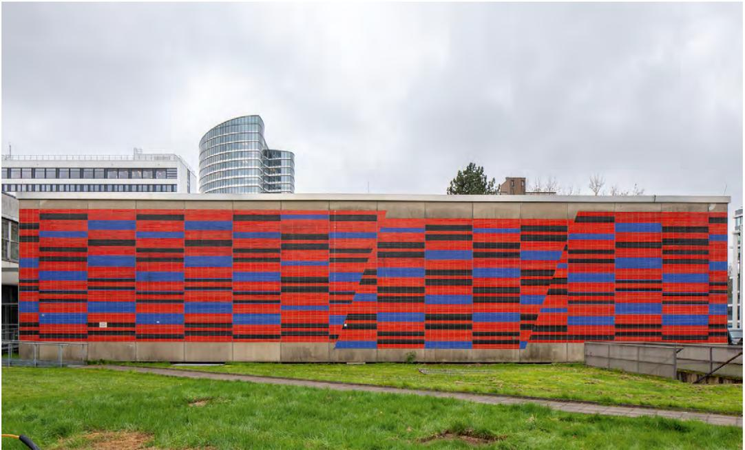
**2 | Die Betonplattenbreite ist Grundlage der horizontalen Reihungen, die im Mittelteil durch eine schräg abrutschende Zone dynamisiert werden.**
