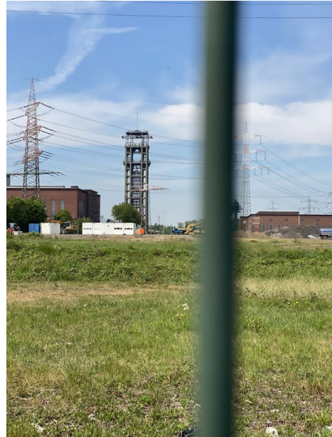
Abb. 2: Turmgerüst des Bergwerks Walsum im April 2025 (Foto: D. Gür-Şeker)
